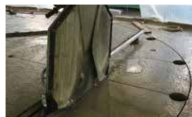
Taglio di sezionatura esecuzione sezioni
