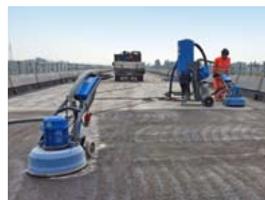
Le levigatrici Tyrolit all'opera su un viadotto.
