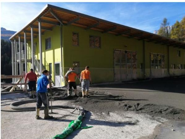
realizzazione di sottofondi di pavimentazioni sensibili all'umidità. Aggregato leggero che, grazie alla sua struttura cellulare racchiusa in una scorza clinkerizzata, ottimizza il rapporto tra peso e resistenza, si indirizza in particolare alla realizzazione di isolamenti termici.
