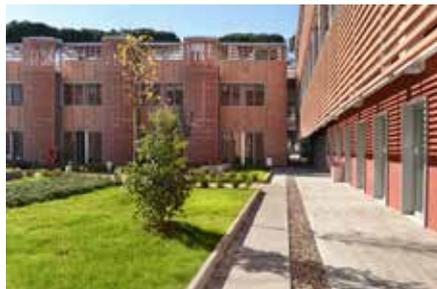
L'uso del **Lecablocco Bioplus A+** ha permesso di ottenere tutti i vantaggi statici di una struttura scatolare unitamente a quelli di comfort abitativo grazie al suo elevato grado di isolamento e inerzia termica.
