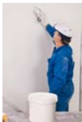
ThermoShield può essere applicato a pennello, a rullo o a spruzzo.
